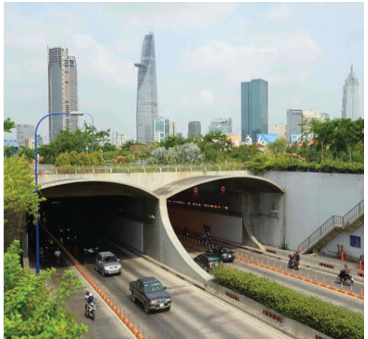
Hầm Thủ Thiêm / Thu Thiem Tunnel
