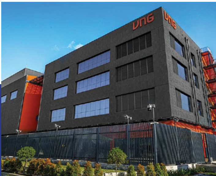
VNG Data Center
